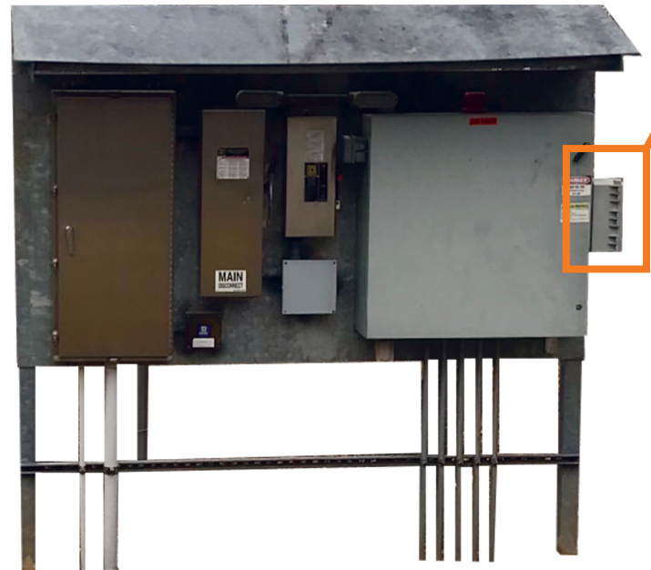
Quadro di controllo principale associato a un pannello integrativo DERAGGER®
